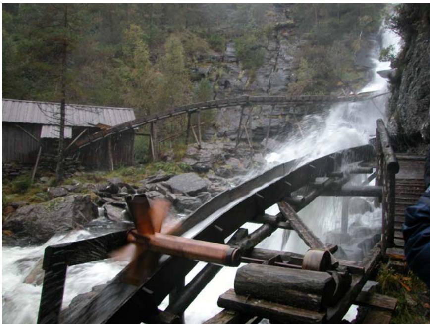
Ved siden av husene i hovedtunet på Hustveit er det en interessant gruppe bygninger ved Kvednafossen. Her finner vi kvernhus, korntørke, sag og buhus.
