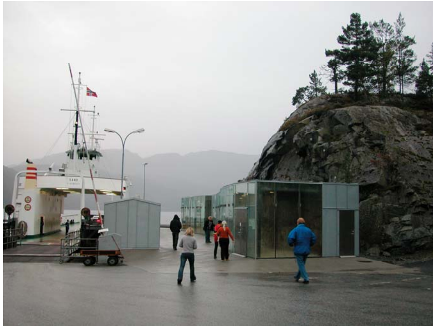
Det nye servicebygget på Ropeid er et av tiltakene i det nasjonale prosjektet Norske Turistveger – med landskapet som grunnlag for verdiskaping og opplevelser. Arkitekt: Jensen og Skodvin arkitektkontor AS. Byggherre: Statens vegvesen.
